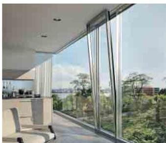
Die Verschmelzung von Form und Funktion – höchste Transparenz durch Flügel, die von außen Festfeldern gleichen, und Wärmedämmwerte, die Passivhaus-Niveau erreichen.
