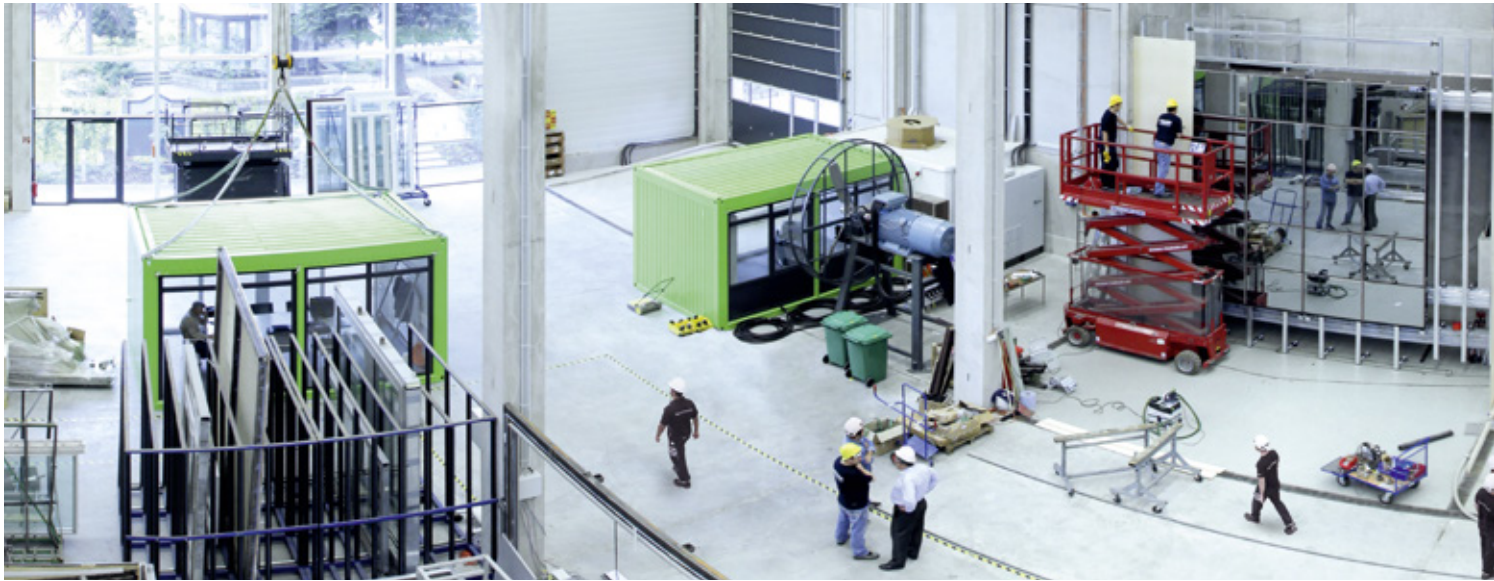
Schüco Fassadenprüfstand Schüco façade test rig
