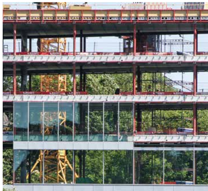
Façadă din elemente: Montajul elementelor Unitised façade: Unitised assembly
