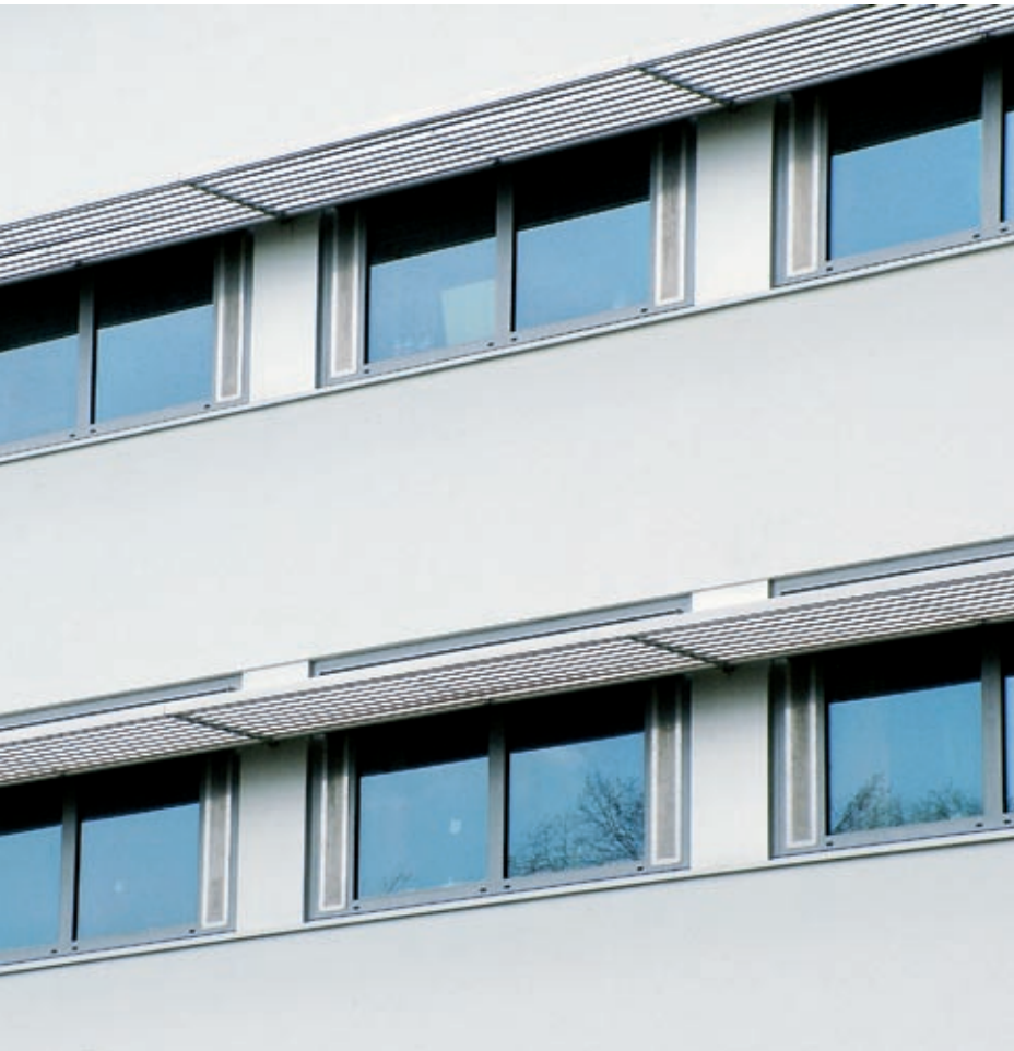
Bezirkskrankenhaus, Kaufbeuren, Deutschland District hospital, Kaufbeuren, Germany
