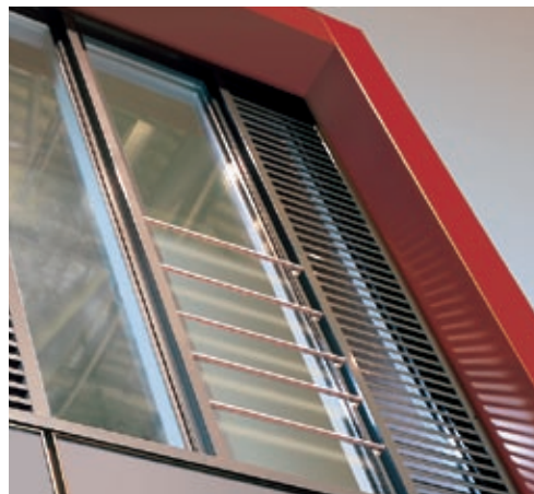
Sicherung durch Edelstahlstäbe – In Bereichen mit hohen Sicherheitsanforderungen sind Sicherungsstäbe aus Edelstahl unerlässlich Stainless steel bars provide security – In high-security areas, stainless steel security bars are essential
