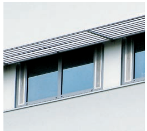
Schmalere Drehflügel – In vielen Objekten haben sich Festverglasungen und Flügel als Dreh- oder Kippflügel bewährt. Durch den nur 120 mm schmalen Durchgang lassen sich Lüftungsfunktionen realisieren, ein Durchtritt wird jedoch ausgeschlossen Narrow side-hung vents – In many projects, fixed glazing and side-hung and bottom-hung vents have proven reliable. The 120 mm narrow opening width allows for ventilation but prevents anyone getting out
